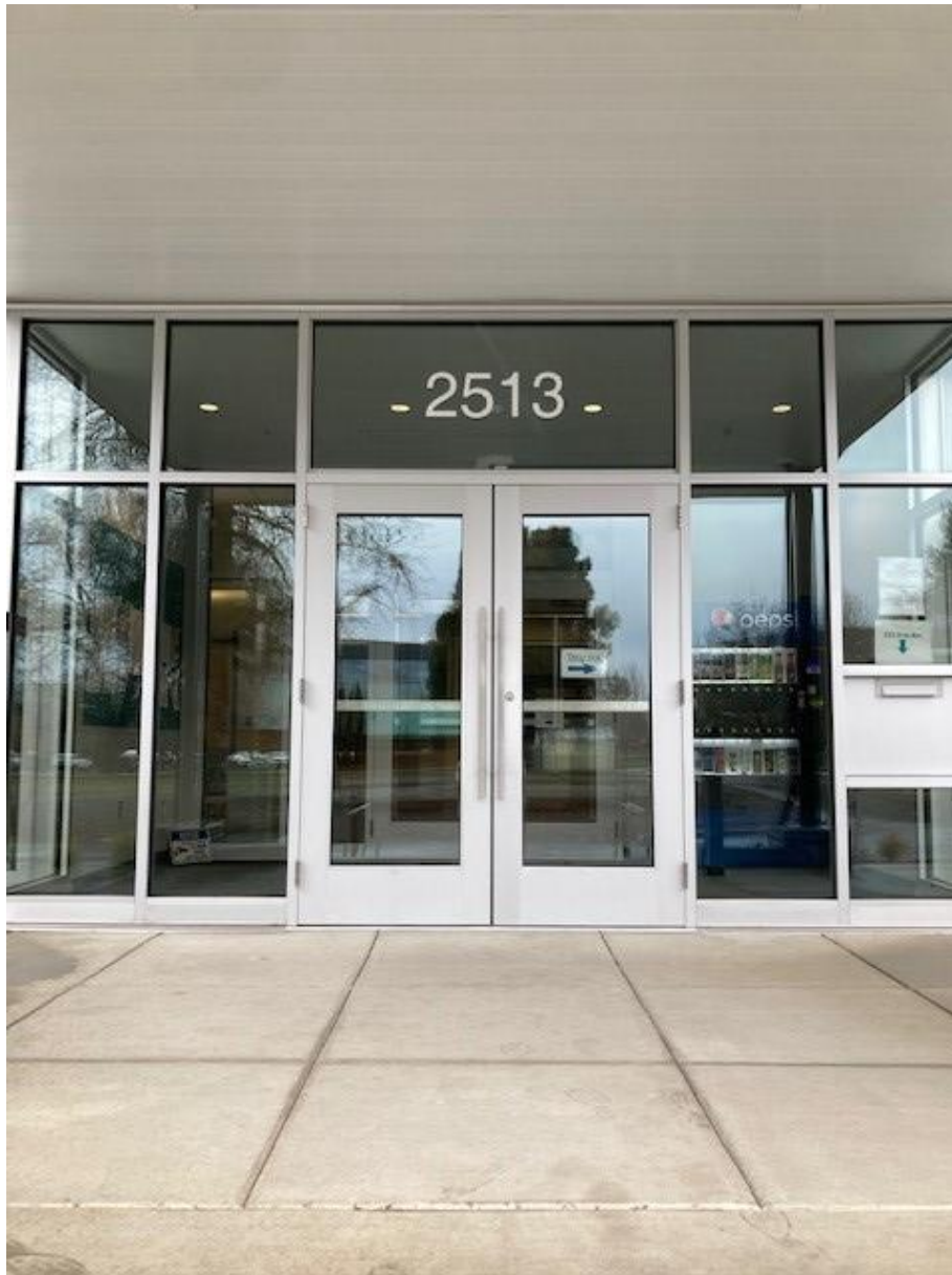
Entrada principal al edificio LCDDS.
